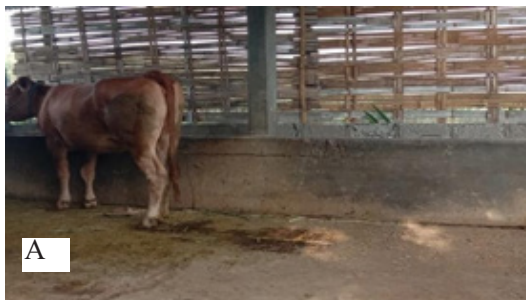
Gambar 3. Kondisi lantai kandang A
